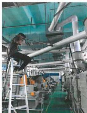
喷砂车间17号机废气处理前取样口
