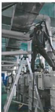
喷砂车间18号机废气处理前取样口
