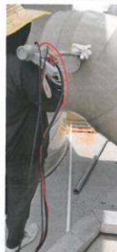
蚀刻车间6#废气处理前取样口
