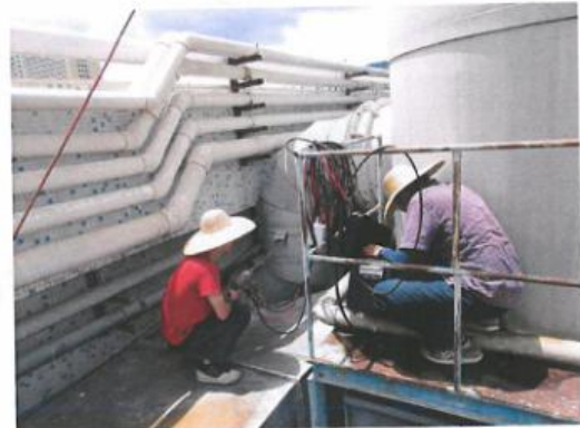
7楼粉尘废气1#排气筒处理前取样口
