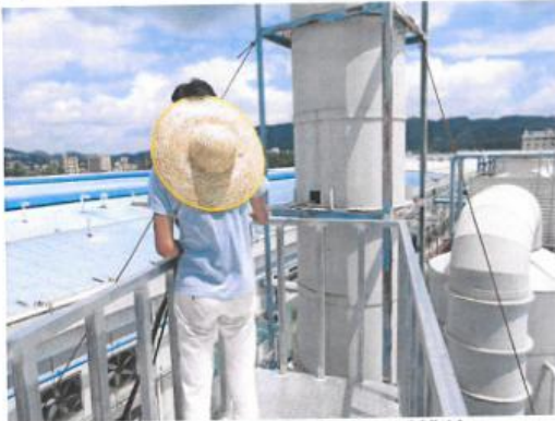
7楼粉尘废气1#排气筒处理后排放口
