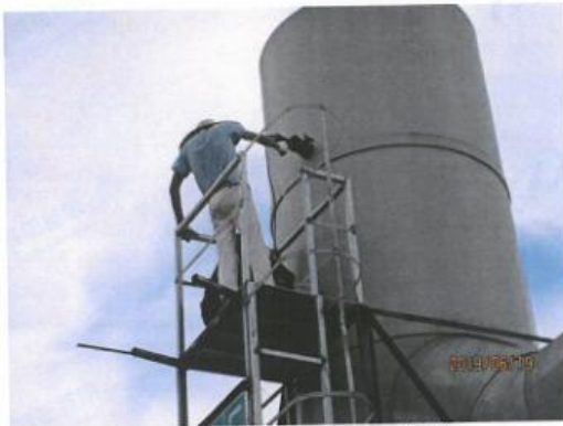
3栋丝印、喷墨废气处理后排放口
