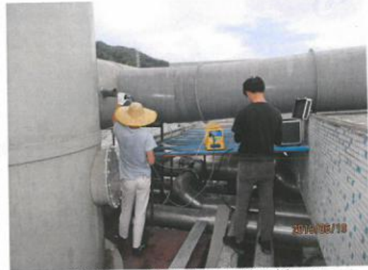
3栋丝印、喷墨废气处理前取样口2#
