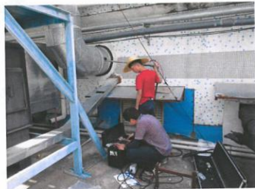
7楼粉尘废气3#排气筒处理前取样口
