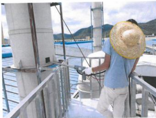
7楼粉尘废气2#排气筒处理后排放口
