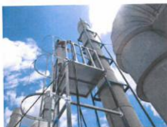
7楼粉尘废气3#排气筒处理后排放口
