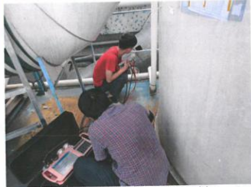
7楼粉尘废气2#排气筒处理前取样口
