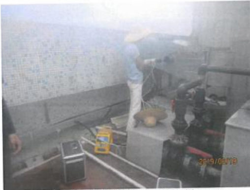
3栋丝印、喷墨废气处理前取样口1#
