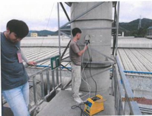
4楼丝印、喷墨废气处理后排放口
