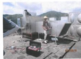
油烟废气处理后排放口
