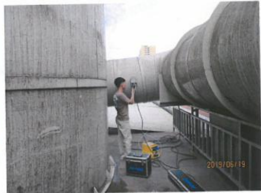
4楼丝印、喷墨废气处理前取样口
