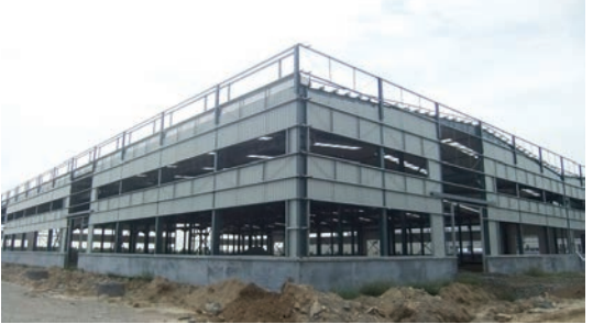
5号车间现场围护结构施工。
