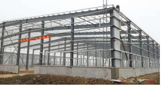
钢构厂房四标段墙面檩条完成。
