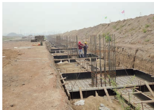
1号车间基础承台正在进行施工。
