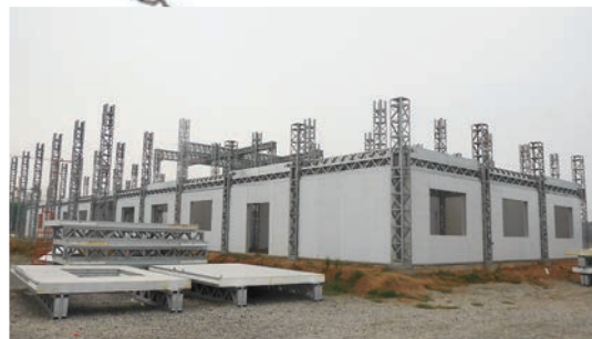
新材样板房正在安装墙板。
