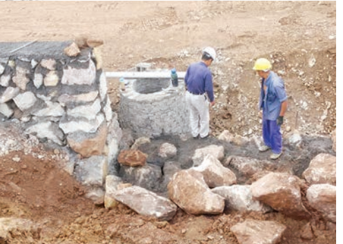
建筑工人正在砌筑挡土墙。
