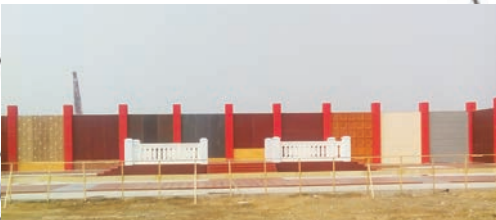
样板展示厅已施工完毕。
