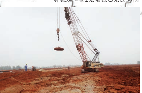
大型桩机进行桩基施工。
