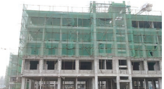
办公生活区2'、3'、4'宿舍楼封顶。
