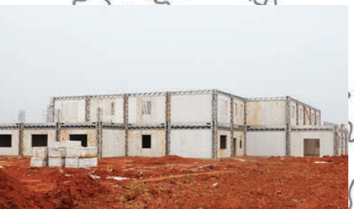
样板房工程2层墙板已完成50%。
