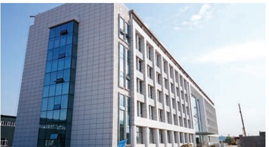
办公楼幕墙建设完成。
