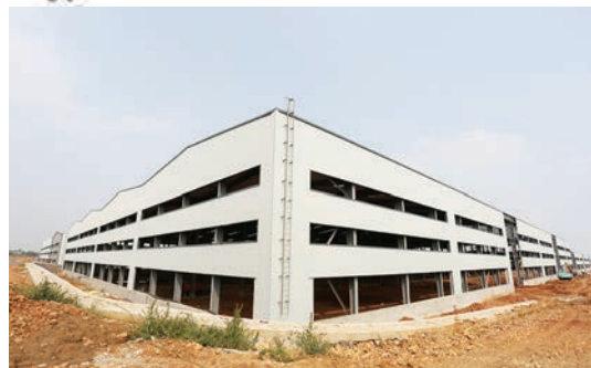
三号原料库已完成外墙保温作业。
