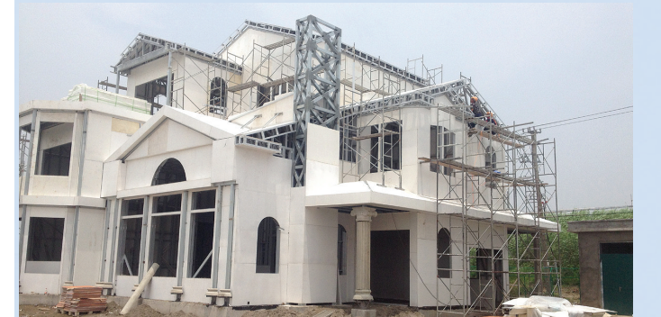
三层别墅样板房基本完工
