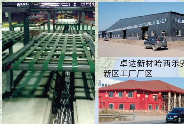
卓达新材哈西乐安新区工厂正加紧安装调试设备 新区工厂样板楼
