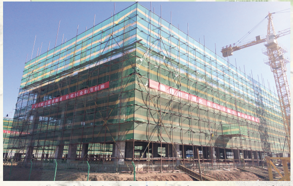
施工中的张掖卓达新材产业园员工宿舍楼
