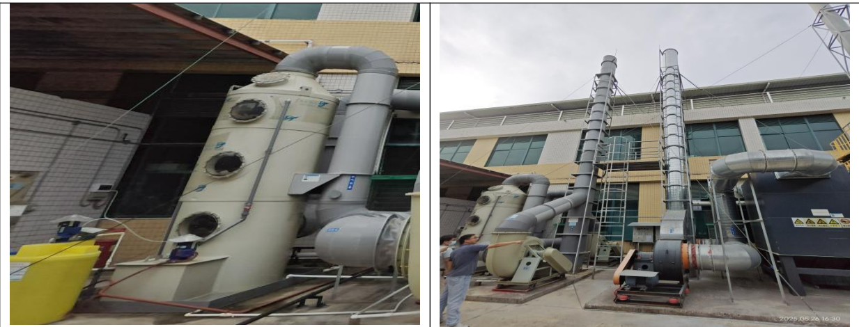
水喷淋装置照片 1#
