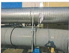
有机废气处理前采样口 2#
