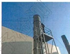
有机废气处理后采样口
