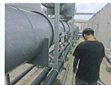
酸雾废气处理前采样口
