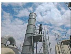
酸雾废气处理后采样口
